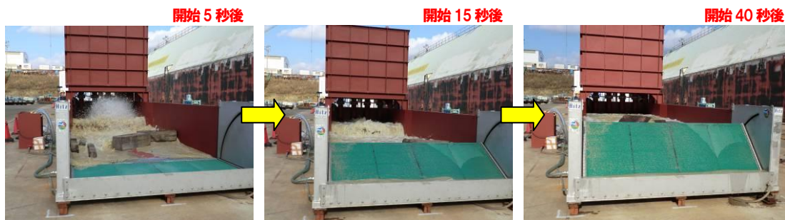
図3 段波状津波によるフラップゲート扉体の起立の様子
