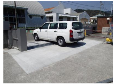
車両走行確認
